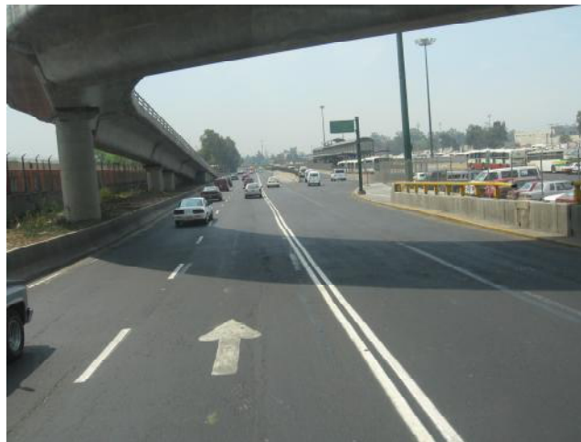
Figura 4.2.4 Vista del Corredor 17 en Indios Verdes.
